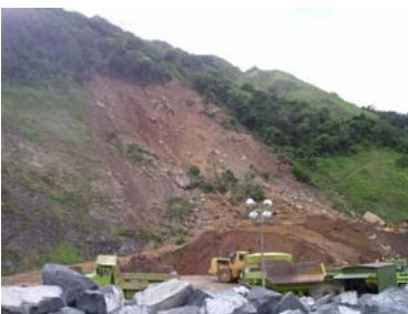
Deslizamiento de tierra en la PR10 para el año 2004. Foto por: Dr. James Joyce
